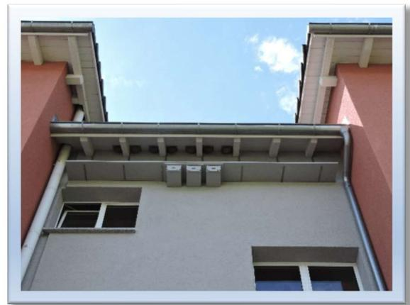
*Kombinierte Mauersegler- und Mehlschwalbennisthilfen mit Kotbrett (Foto Urs Wüst)*
